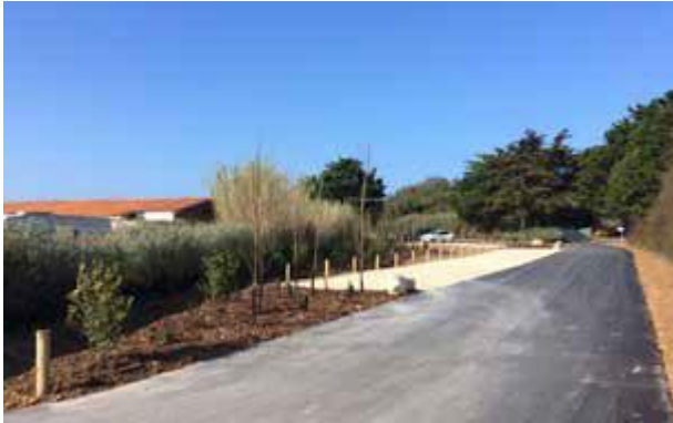
Aménagement du parking du phare de la baleine en Charente-Maritime
